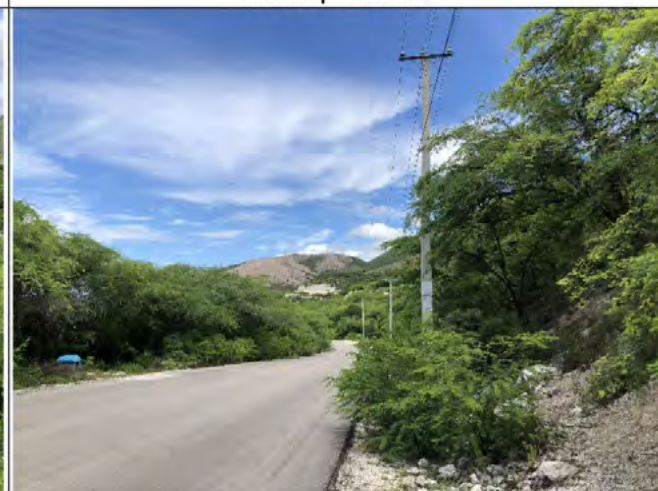
Área quemada, vista desde la carretera
